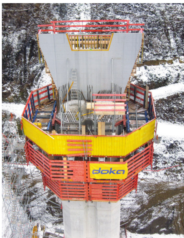
Für die sichere Montage der Pfeilerkopfschalung wurden die hochgeklletterten Pfeilerkopfbühnen der Selbstkletterschalung SKE100 plus wiederverwendet.
