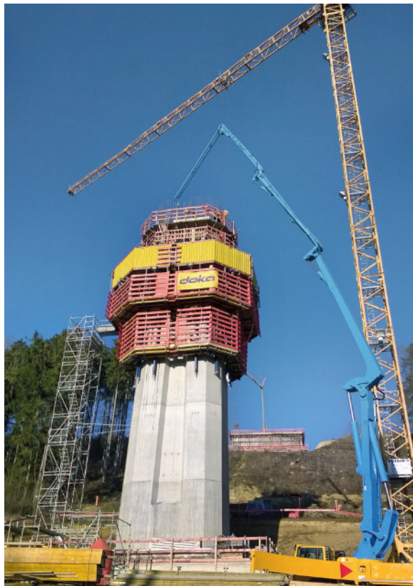
Für die Betonage der Pfeiler kam die vollhydraulische Selbstkletterschalung SKE100 plus zum Einsatz.
